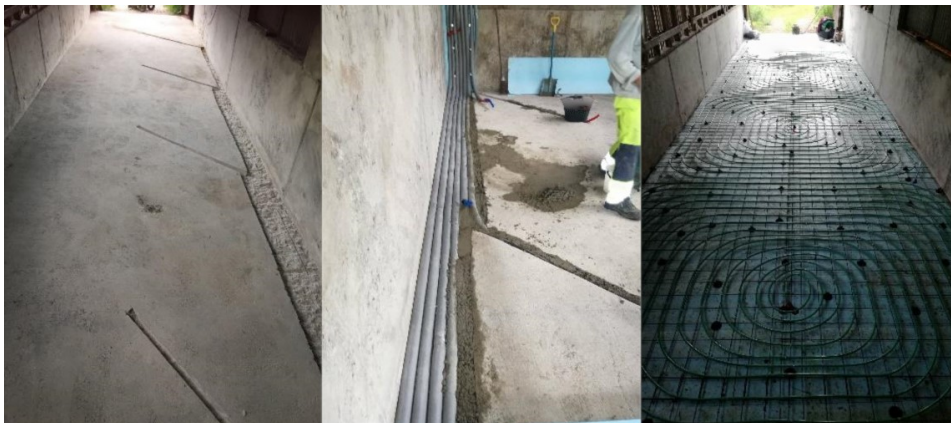
Kuva 1 Lantalan lämmöntalteenoton rakentaminen (Ahlqvist 2020)
