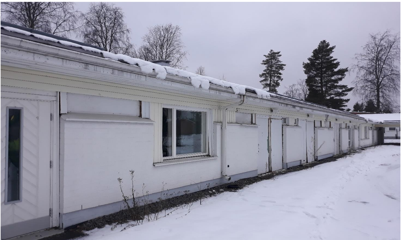
Kuva 1. Purettava rivitalo Simon kunnassa
