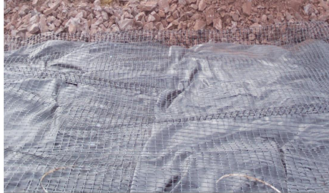
Valokuva kahden 450 mm päässä toisistaan olevan lujiteverkon asennuksesta kun murskattua kiviainesta on käytetty lujittumiskerroksessa.
