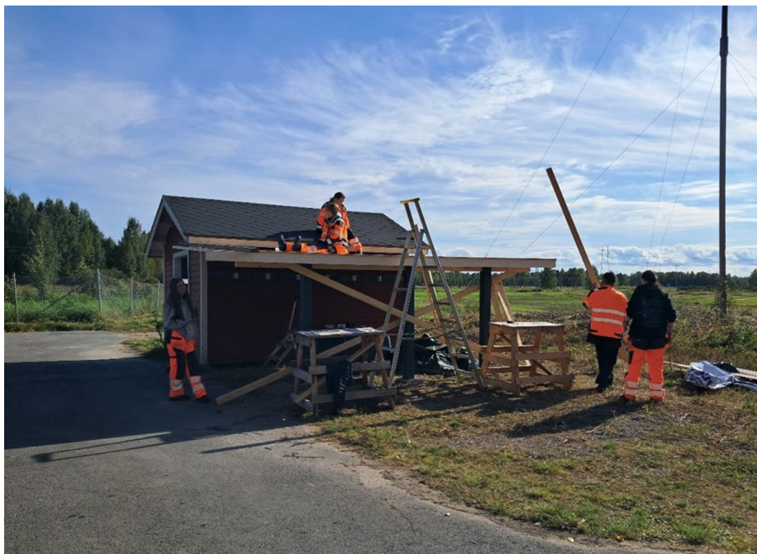
Kuva 1. Lisäkatoksen rakentaminen opiskelijoiden kanssa kompostorien talvihuoltoa helpottamaan (Pauliina Myllylä)
