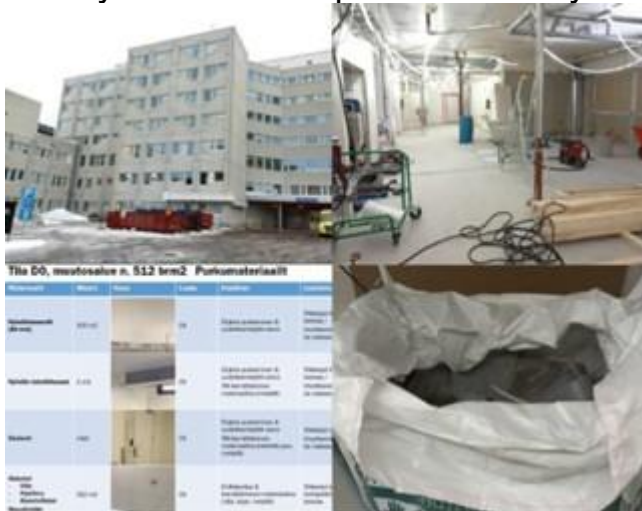
Kuvio 4. Lapin keskussairaalan korjaustyömaan pilotti (Vatanen 2025)
