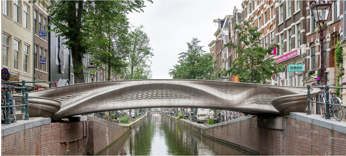
Kuva1. WAAM-menetelmällä tehty silta (MX3D 2024)
