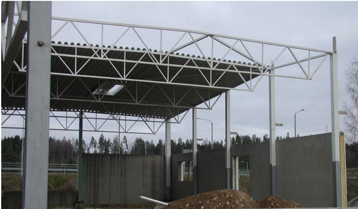
Kuva 2. S-market Urjalan teräsrakennetta (Teräsrakenneyhdistys 2023)
