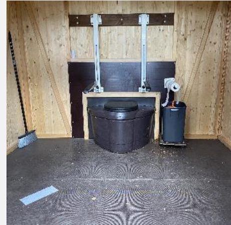
Alku/päätepisteen wc. Wc-istuimen korkeus 43 cm.
